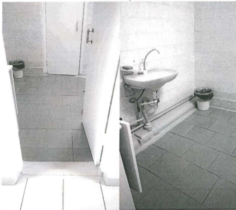
12. Вход в санузел, умывальное помещение Фото 31, 32
